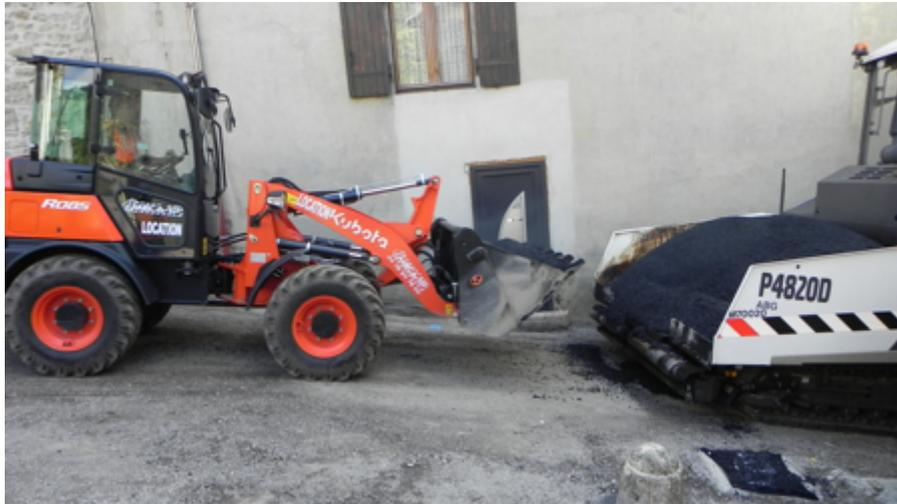
Les travaux de remplacement du réseau d'eau potable étant achevés rue du Genod, l'entreprise Eiffage a procédé à la pose d'un nouveau revêtement en enrobé en remplacement du précédent, détruit lors des travaux, pour un montant de 53 644 euros TTC.
