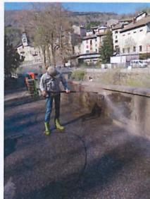
Commencée l'an dernier par la peinture des barrières en centre ville, l'opération "embellissement et propreté" de la Commune se poursuit. Les élus ont choisi fin avril de passer les murets, parapets, et mobilier urbain au nettoyeur à haute pression. Les salissures et la grisaille laissées par le temps ont fait place à de jolies pierres plus claires.
